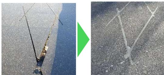
図-12 コイル敷設箇所の舗装剥離（左）と補修状況（右）
