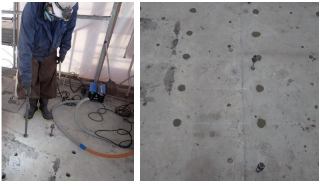
写真-3 耐震補強施工状況（第1期工事）
