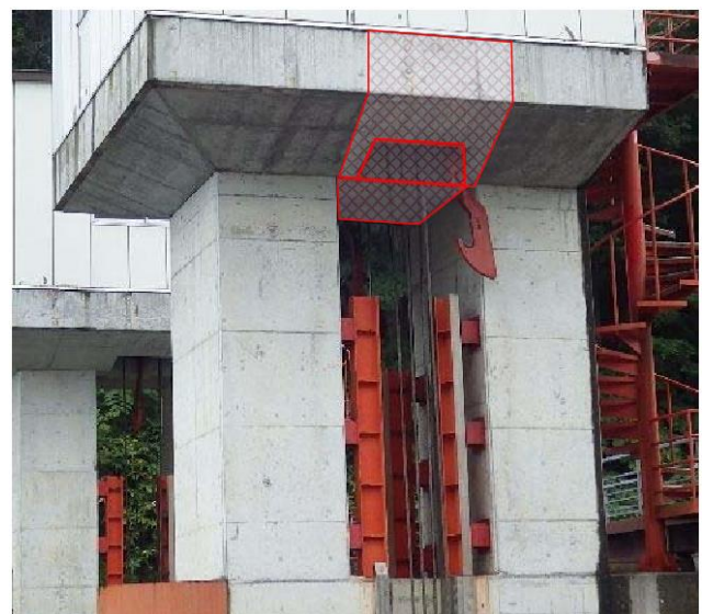
写真-1 P2 堰柱の耐震補強範囲
