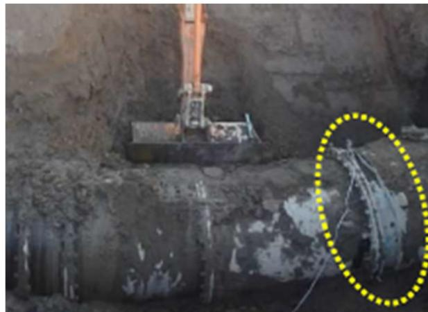
写真-1 道路横断部での管水路離脱
