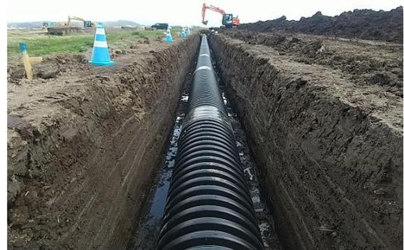
写真-3 埋設中の排水管路
