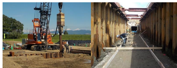
写真-16 電動式バイプロハンマによる鋼矢板打込み(左)と掘削後の断面(右)
