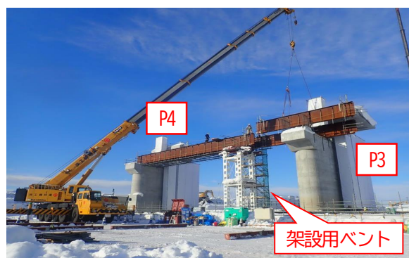
写真-7 管理橋桁架設(架設用ベント)
