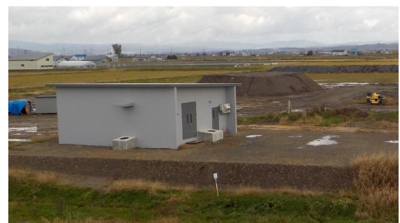
写真-13 完成した管理棟
