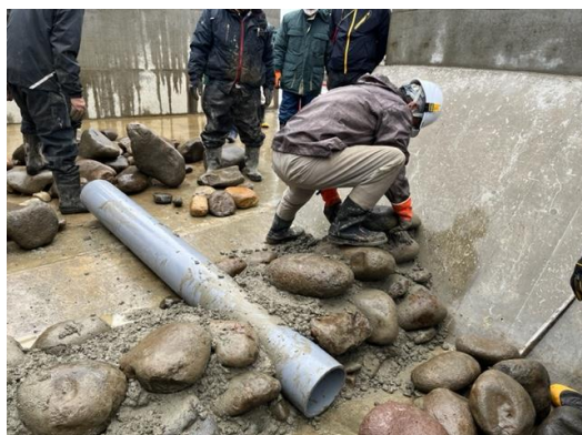
写真-11 魚道工(越流部)の石積み (学識経験者による指導状況)
