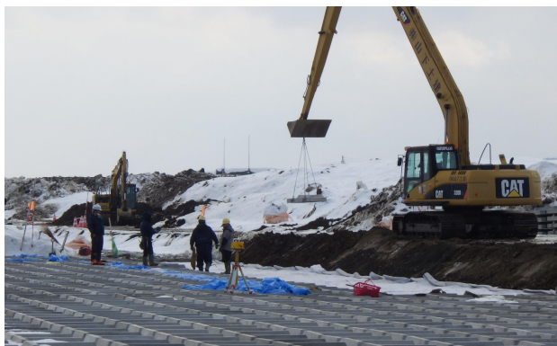
写真-10 右岸側高水護岸敷設状況
