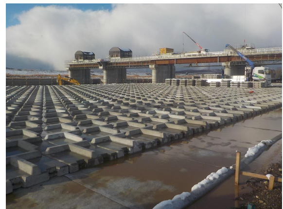
写真-14 令和6年度工事施工状況 (左岸側高水敷護岸敷設状況)
