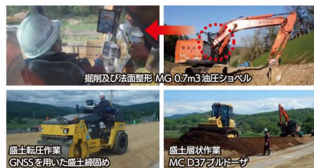
図-11 施工工事の自動化
