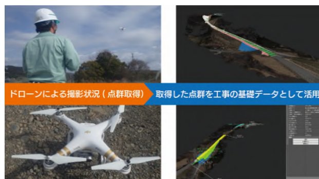
図-3 ドローンによる現況データ取得と土工モデル確認
