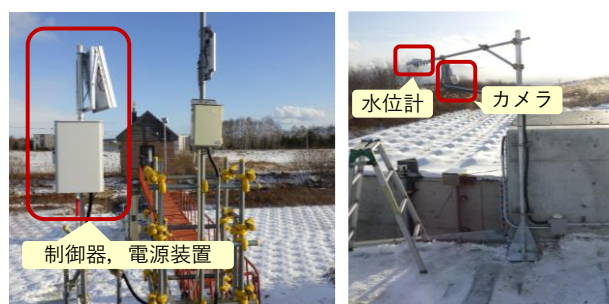
写真-1 設置状況(厚別川 A 樋門 自動開閉ゲート)
