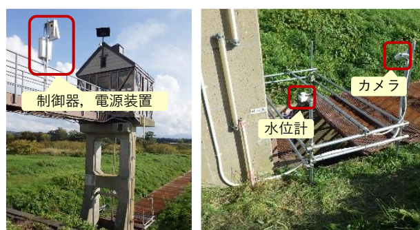
写真-3 設置状況 (今金2号樋門 ローラゲート)
