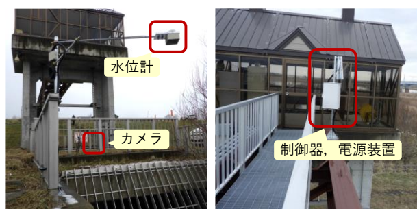
写真-2 設置状況(石狩川本川下流 B 樋門 ローラゲート)
