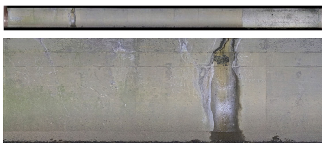
写真-3 オルソ画像（上：函体左側壁全体、下：変状部拡大）
