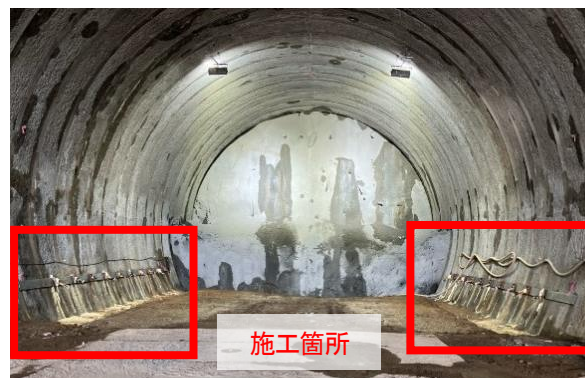
写真-10 サイドパイル施工完了全景
