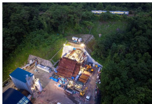
写真-3 パイプルーフ施工状況
