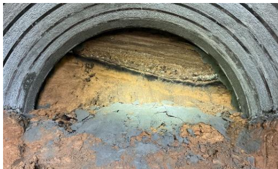
写真-8 切羽崩落
