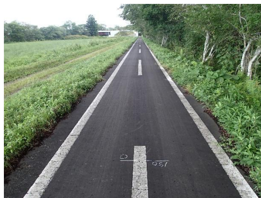
写真一2 路面状況(凍上対策修繕後6年経過区間)
