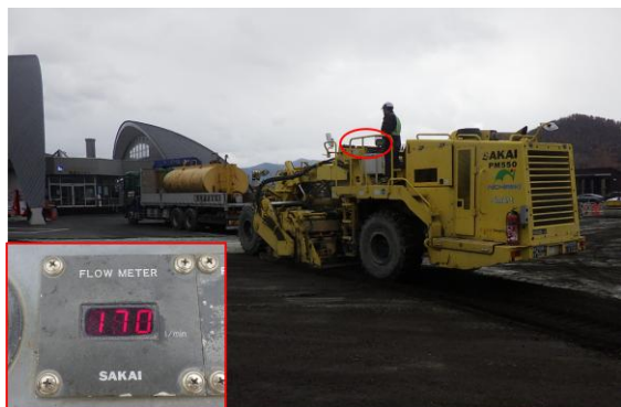
写真-6 路盤改良状況 (拡大：乳剤の吐出量)
