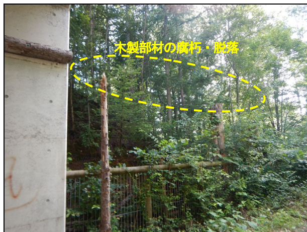
写真-3 老朽化した木製エコブリッジ(令和7年5月)
