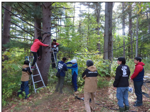
写真-6 帯広畜産大学構内でのロープ型エコブリッジ設置状況（令和7年10月）
