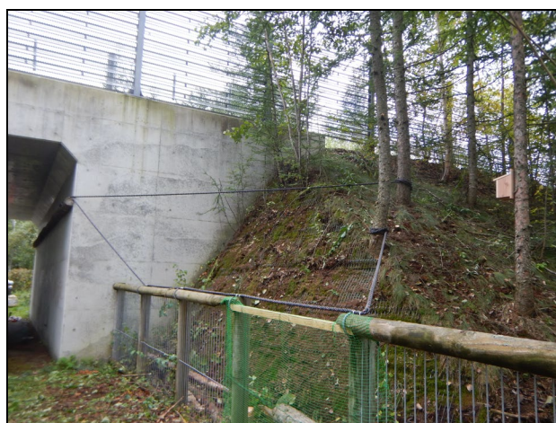
写真-5 ロープ型エコブリッジ設置完了（令和7年9月）
