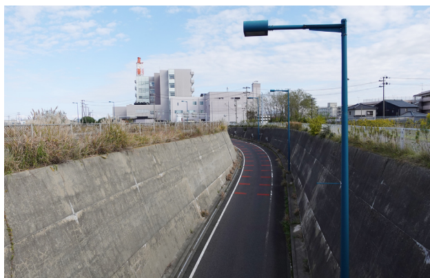
写真2 北向きコンクリート面の汚れ方と見え方の違い 新潟みなとトンネル（新潟市東区） 2025年11月6日13時頃撮影
