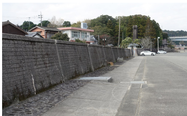
写真3 北向きコンクリート面（北北西向き）における縦スリットによる分割の事例とその効果の例 宮崎県日向市、2024年12月17日12時頃撮影
