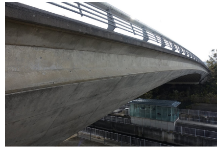
写真4 コンクリート表面の造形的工夫と天空光による陰影によってコンクリート面の印象を分割する工夫の例 1) ( 塵芥汚れの少ない垂直面であれば、直射日光のない環境下でもこのような陰影を創出できる。)
