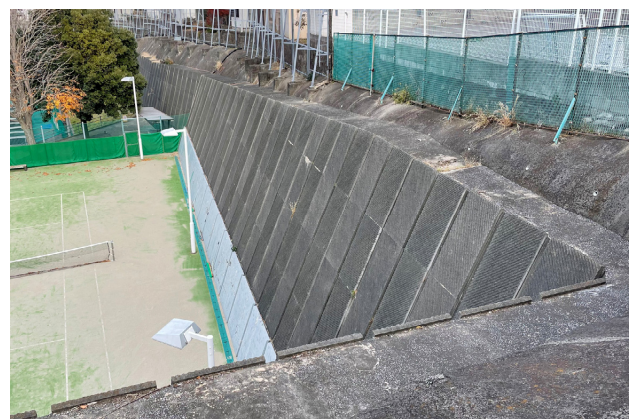
写真6 直射日光のない環境下でも化粧型枠による斜め 45° のスリット文様が部分的に切り替えられることにより創出されるコンクリート面の明暗 1) 横浜市神奈川区（西北西向き面） 2024 年 12 月 13 時頃撮影
