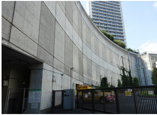
写真4 コンクリート表面の造形的工夫と天空光による陰影によってコンクリート面の印象を分割する工夫の例 1) ( 塵芥汚れの少ない垂直面であれば、直射日光のない環境下でもこのような陰影を創出できる。)
