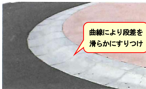
図-13 山形県長井市平山の除雪に配慮したエプロン段差事例 （ラウンドアバウトマニュアル2021 p. 86に加筆）
