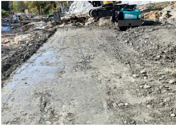
写真-3 CSG締め固め状況
