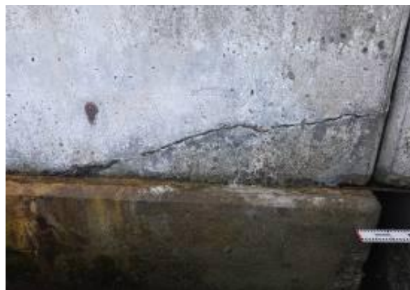
写真-1 干満帯に発生したひび割れ（苫前漁港）
