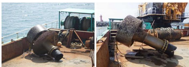
写真4 既設取水管（引き上げ時）の様子
