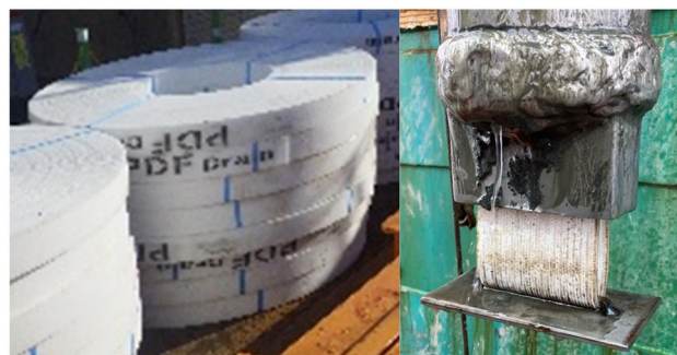
写真-4 ドレーン材（左）と先端アンカー取付状況
