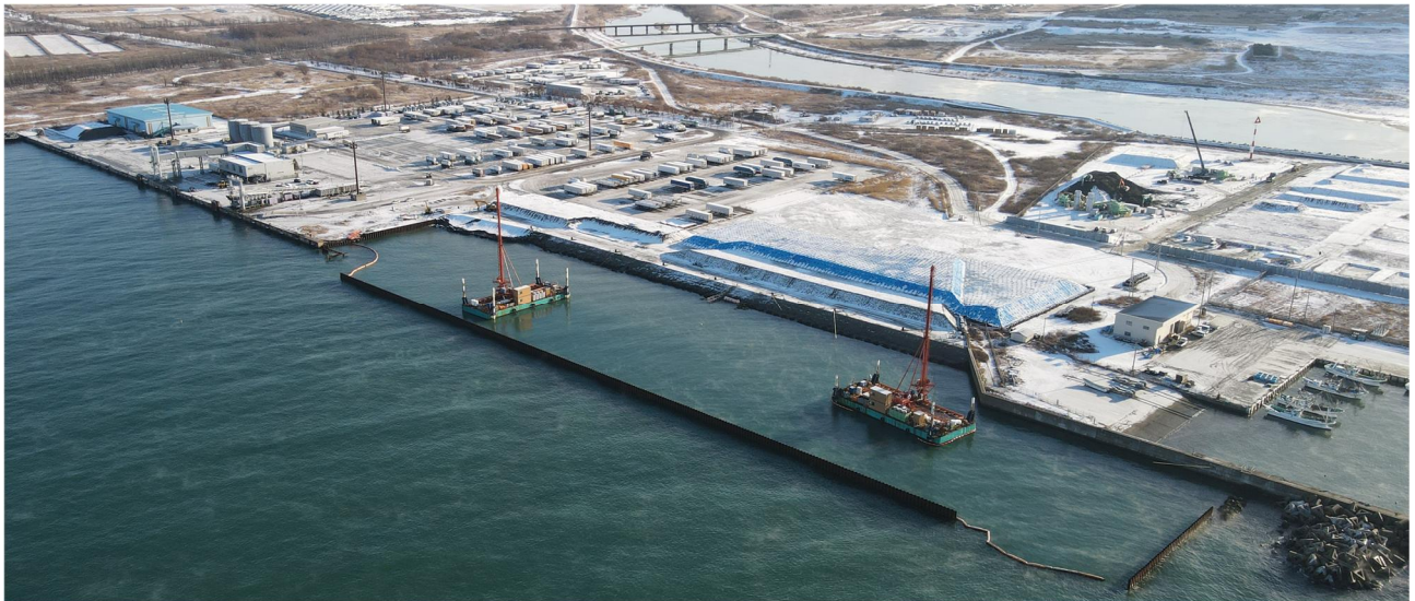
写真-6 閉水域（仮設鋼矢板内）でのPDF台船2隻による同時施工状況
