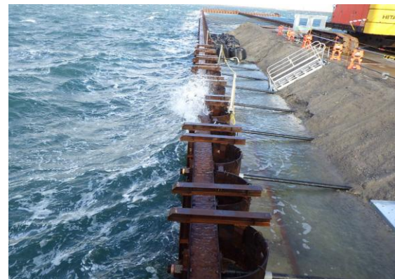
写真-3 時化による鋼管矢板の越波状況
