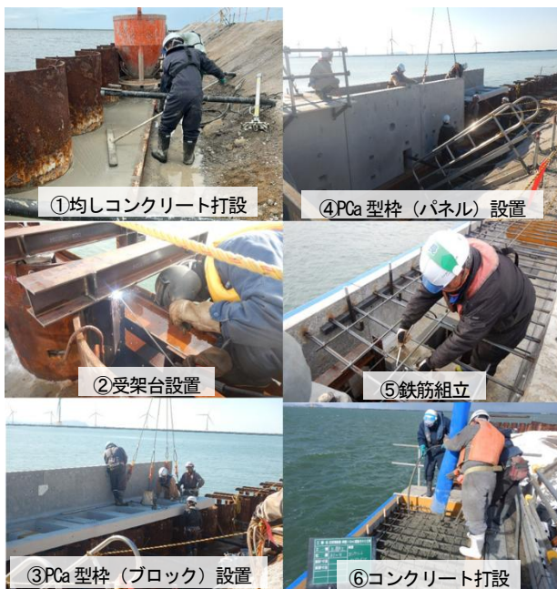
写真-2 PCa 型枠による上部工の施工
