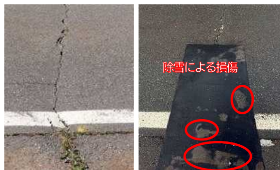
図-11 ⑦注入材+クラック抑制シート+パッチ（As合材） （左：R7.9（施工前）、右：R7.10施工）
