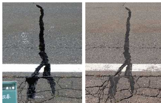
図-5 ①注入材のみ(左: R6.10、右: R7.9撮影)
