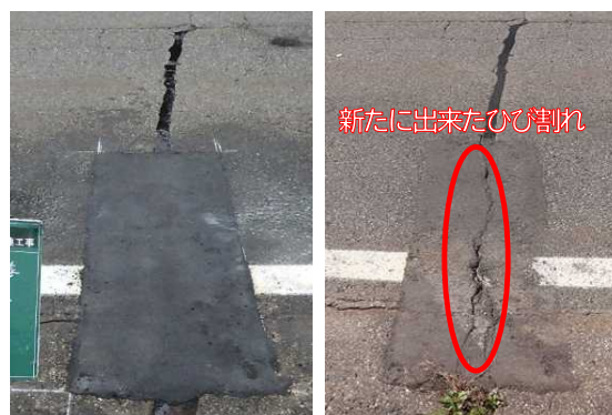
図-9 ⑤パッチ（As合材）+注入材（左：R6.10施工、右：R7.9撮影）
