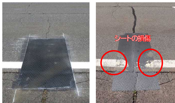
図-6 ②シート張りのみ（左：R6.10施工、右：R7.9撮影）
