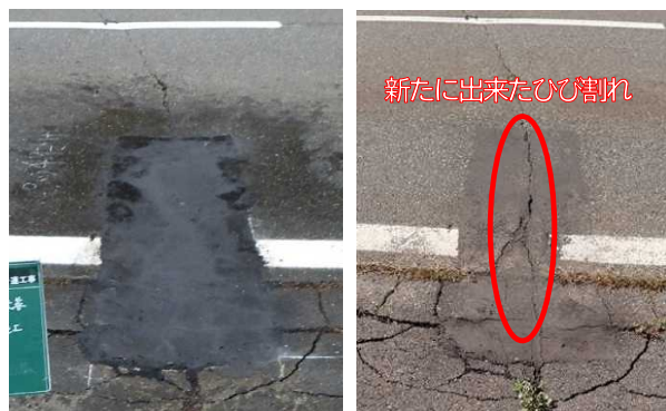
図-8 ④パッチ（As合材）（左：R6.10施工、右：R7.9撮影）
