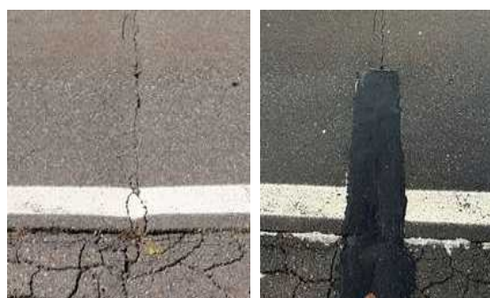
図-10 ⑥舗装材（高弾性・充填タイプ） （左：R7.9（施工前）、右：R7.10施工）
