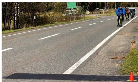
図-22 協議会メンバーによる横断クラック補修箇所の走行状況
