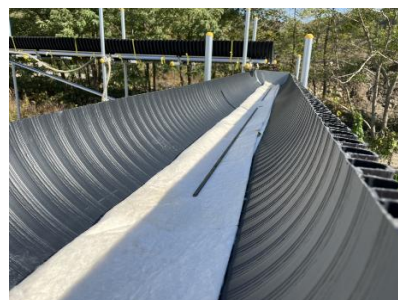
写真-4 仮設排水管内に敷設した植物繊維の状況
