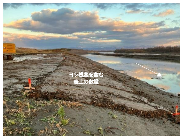
図-10 低水路掘削箇所への表土の敷設状況
