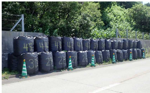
写真-2 耐候性大型土のうの設置例
