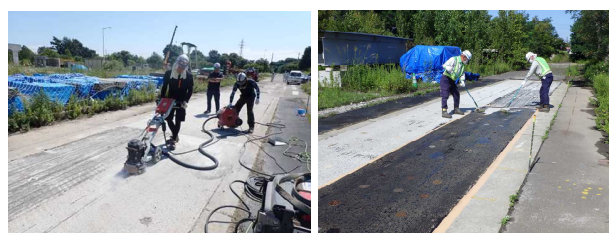
a. 切削後の表面研掃（区画 2B） b. 高浸透型プライマーの塗布（区画 2C） 写真-2 施工状況の例（シリーズ 2）
