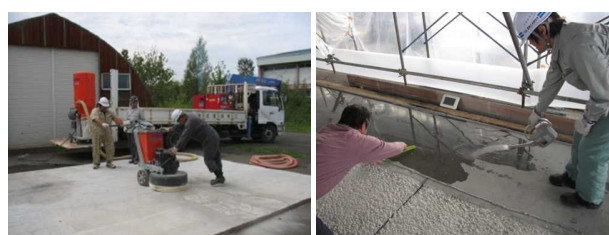
a. レイタンス除去 b. 散水 写真-1 施工状況の例（シリーズ 1）
