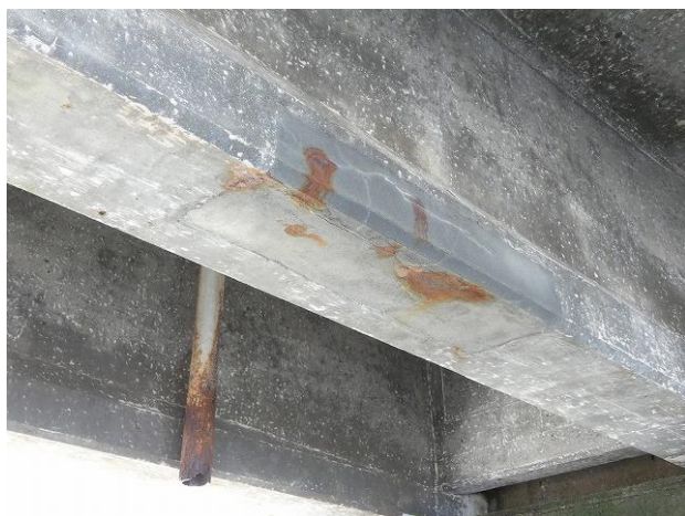
写真-2 断面修復部の背面側の既設部で発生したマクロセル腐食（道南地方の道路橋）
