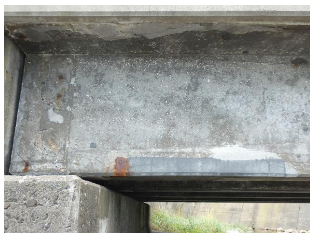
写真-1 断面修復部に隣接する既設部で発生したマクロセル腐食（道南地方の道路橋）
