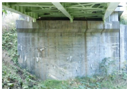
写真-1 橋台のASR劣化状況の一例（北海道）
