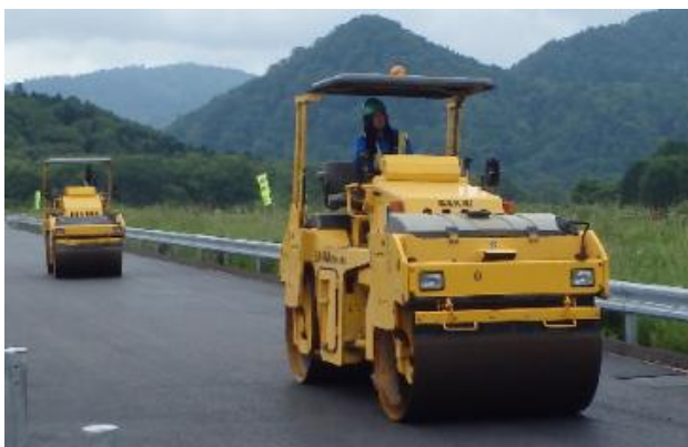
写真-3 水平振動工区の転圧機械および施工状況
