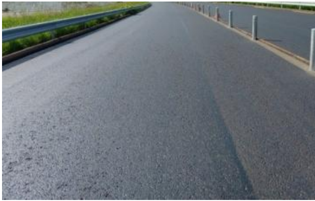
写真-1 試験施工箇所の状況（施工前：基層施工後）
