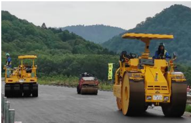
写真-2 通常工区の転圧機械および施工状況
