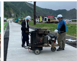
写真-15 カッター切断後の目地材注入
