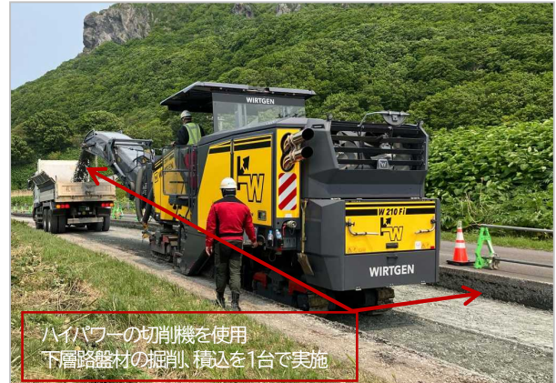
写真-3 切削機による路盤掘削
