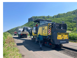
写真-16 アスファルト舗装版の撤去の状況 (写真左：本現場 写真右：他現場の事例)
