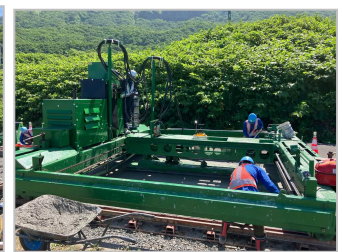
写真-12 コンクリートレベラによる最終仕上げ
