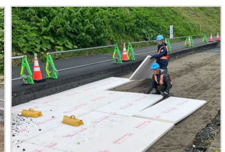
写真-5 断熱材設置
