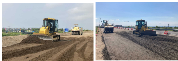
写真-18 他現場での砂の敷均し状況 （右写真：ブルドーザーで材料を押しながら敷均しするため、端部が筋状になっている）
