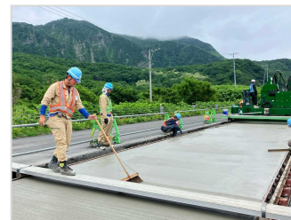
写真-14 人力による粗面仕上げ
