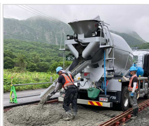
写真-9 コンクリートの打設
