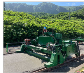
写真-11 コンクリートフィニッシャーによる締固め
