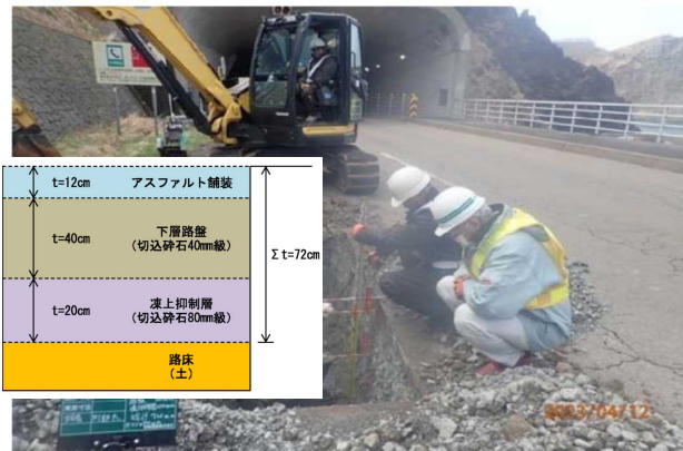
写真-1 試掘調査の結果例（置換厚 t=72\text{cm} ）
