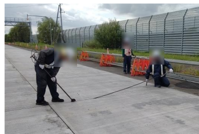
写真-11 バックアップ材の施工状況
