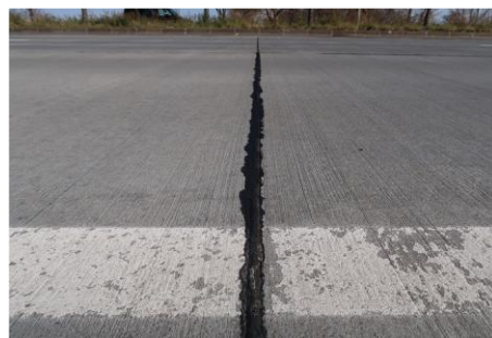
写真-14 バックアップ材なしの区間の目地部の状況
