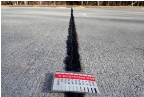
写真-9 目地材のはみ出し
