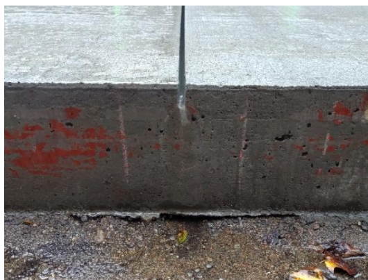
写真-5 目地材注入前の目地部の状況（ひび割れなし）
