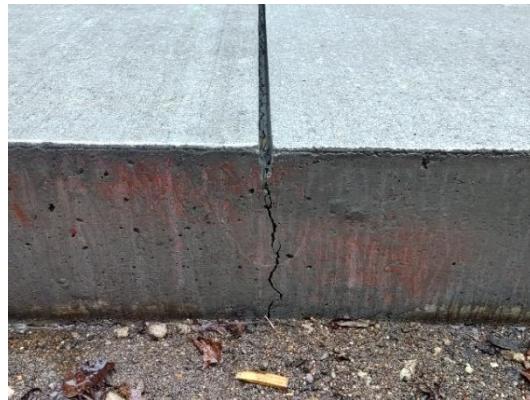
写真-4 目地材注入前の目地部の状況（ひび割れあり）
