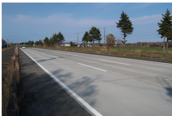
写真-12 施工後のコンクリート舗装
