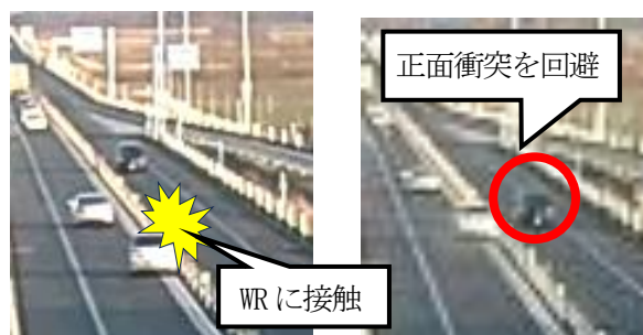
写真1 WR接触による正面衝突の回避
