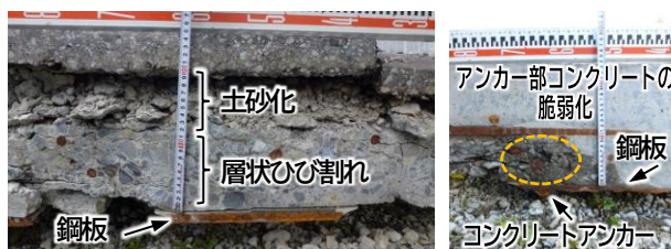
写真-3 アンカー部コンクリートの損傷事例 3)
