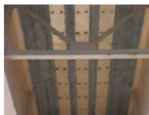
写真-1 鋼板接着補強の例
