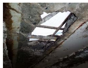
写真-2 床版抜け落ち事例 1)
