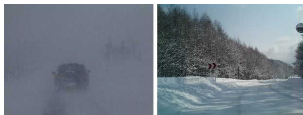
写真-1 吹雪による視界不良（左）と積雪・堆雪による路側線等の隠蔽（右）
