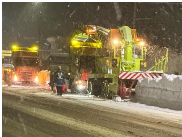
図-1 運搬排雪作業の実施状況
