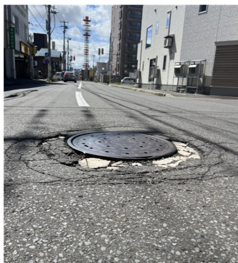
図-1 除雪施工時に障害になり得るマンホールの一例
