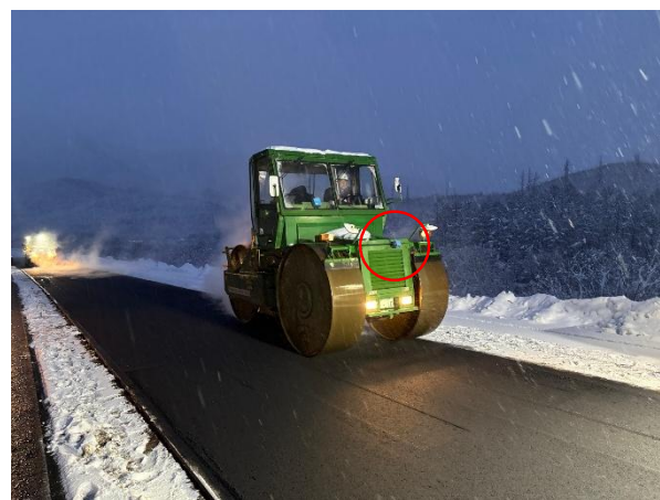
図-8 ローラ搭載型放射温度計
