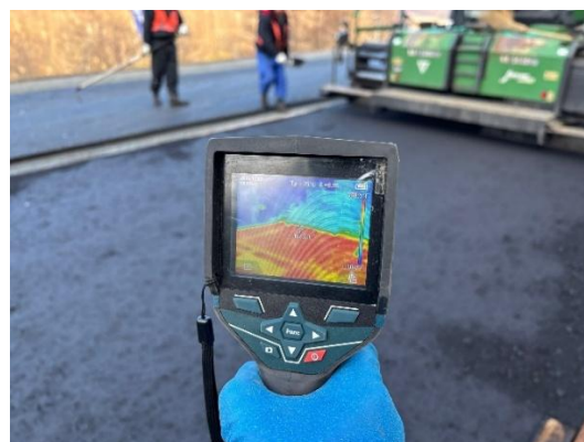
図-9 赤外線サーモグラフィーでの路面温度確認
