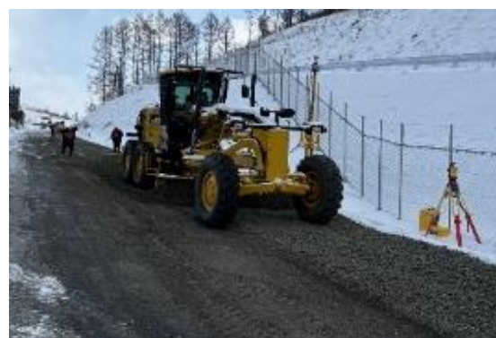
図-3 MCモーターグレーダーでの施工
