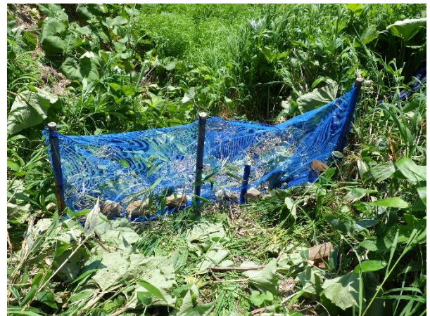
写真-1 流下防止ネットの設置状況
