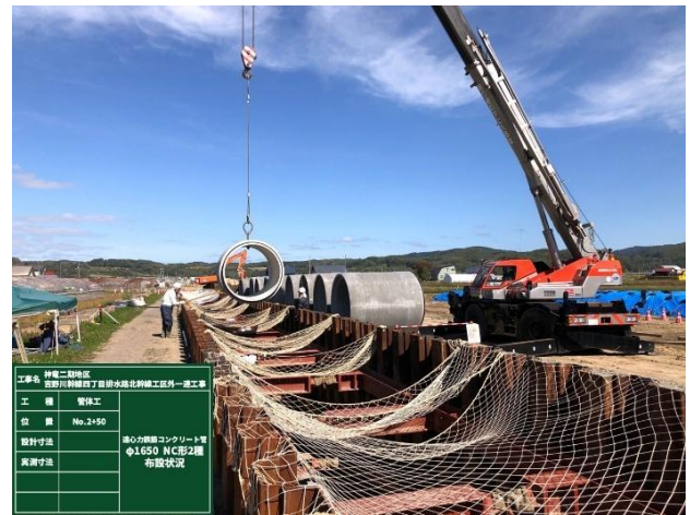
写真-3 令和6年度工事施工状況
