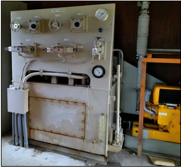
写真-3 電気設備・水管理制御設備の老朽化
