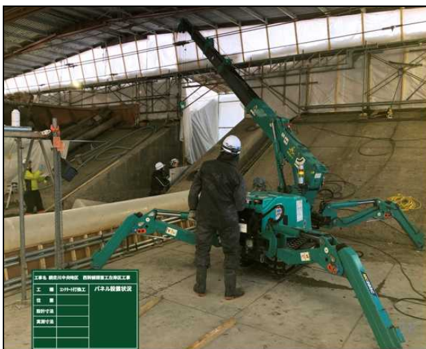
写真-8 小型クレーン使用状況
