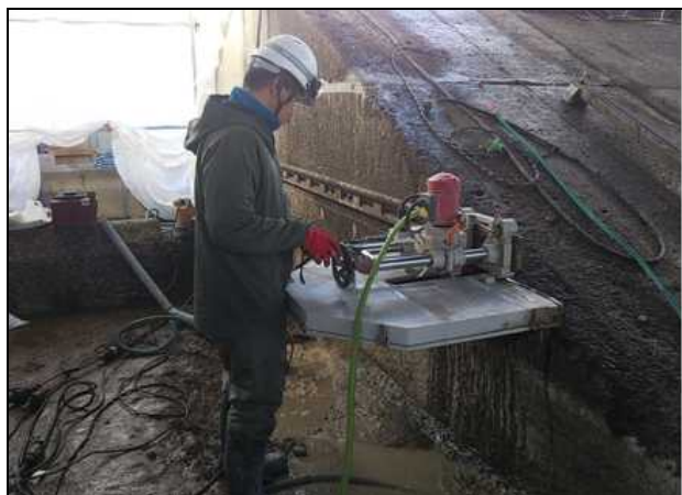
写真-7 ウォールソー工法 施工状況
