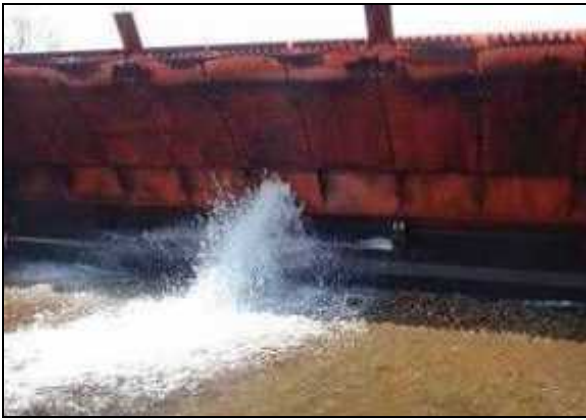
写真-2 ゲートの老朽化
