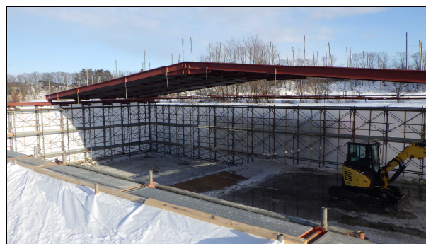
写真-5 仮設上屋(パネル屋根)設置状況
