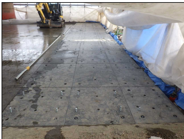
写真-6 超高強度繊維補強コンクリート版設置状況
