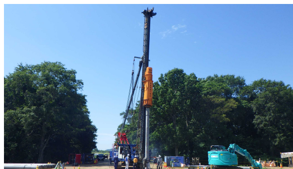
写真-2 杭の打設状況
