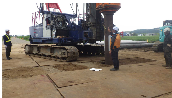
写真-4 ヤットコによる最終打ち込み
