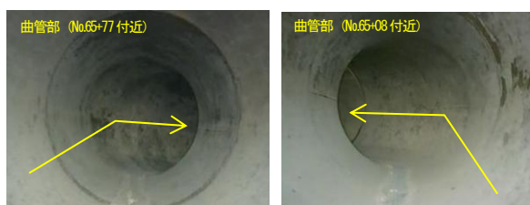
図-3 既設管内調査の状況（曲管部）
