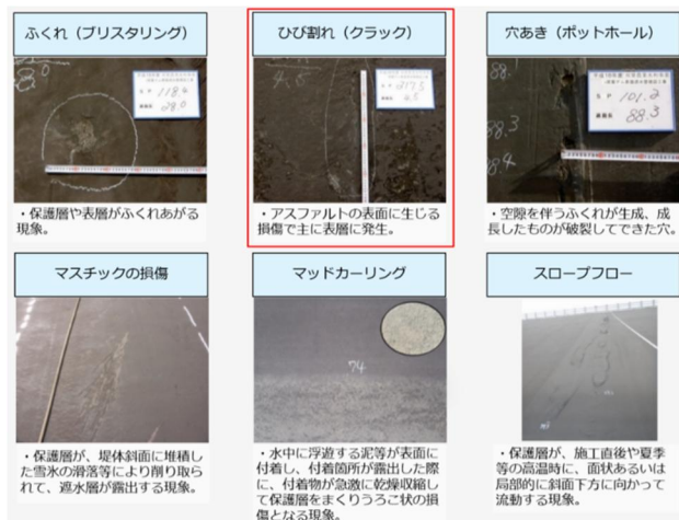
写真-1 遮水壁表面に生じている損傷
