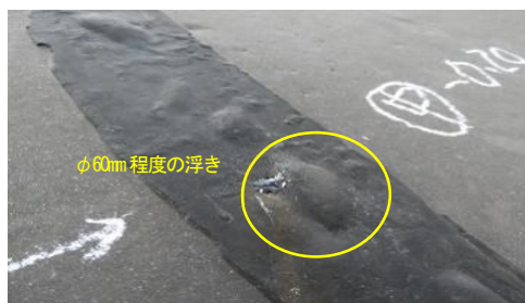
写真-3 補修材の浮き（RC加熱シーラー Uカットなし）
