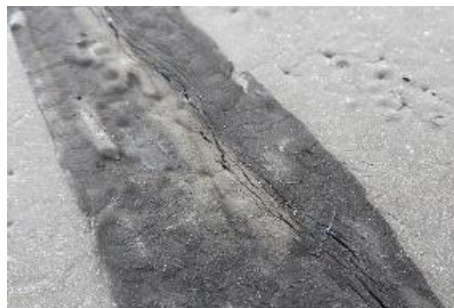
写真-5 補修材の亀裂（クイックスティックUカットなし）
