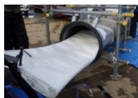
写真-2 更生材設置状況
