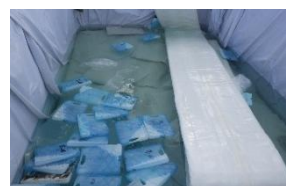
写真-3 更生材冷却状況
