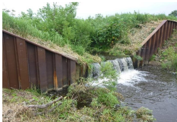
写真-1 鋼矢板落差工
