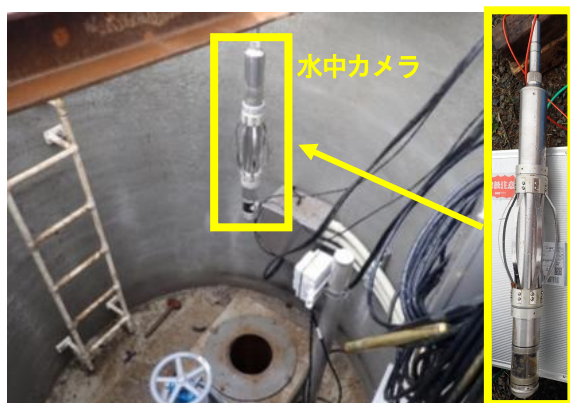
写真-5 水中カメラの挿入状況
