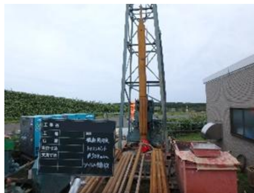
写真-3 対策井戸の掘削状況
