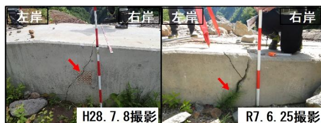
図-4 地すべり末端部の治山施設クラック進行
