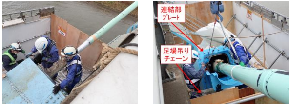
写真-14 定着カバー設置時の状況 (左：ボルト用削孔状況、右：定着部カバー取付状況)
