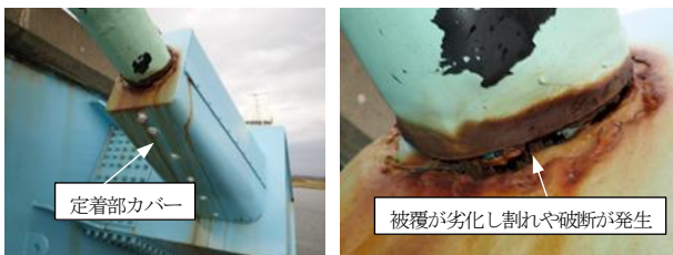
写真-2 斜材ケーブルの劣化状況 (下段) (左: 桁側定着部 右: 桁側定着部拡大)
