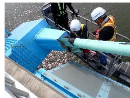
写真-3 PE管撤去
