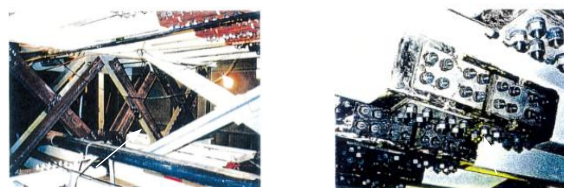
写真-10 鋼床版の大規模補修 (左：対傾構補強 右：縦リブ補強)
