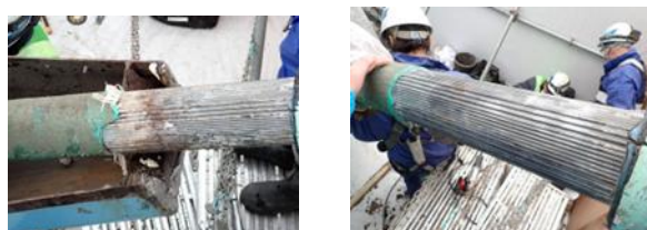
写真-8 斜材ケーブル素線の錆落とし状況（X4ケーブル） (左：ブラッシング前、右：ブラッシング後)
