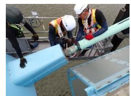
写真-6 プラスチックラッピング撤去
