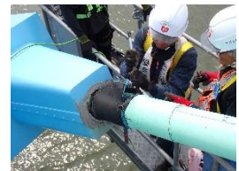
写真-4 熱収縮PEカバー撤去
