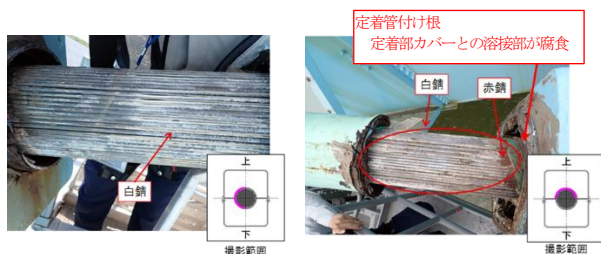
写真-7 斜材ケーブル素線の劣化状況 (左：X8ケーブルの白錆、右：X4ケーブルの白錆と赤錆)
