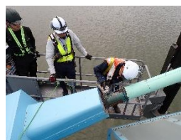
写真-5 定着管撤去
