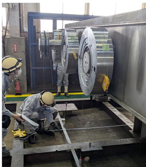
図-1 従来手法での計測（下げ振り、鋼製巻き尺使用）
