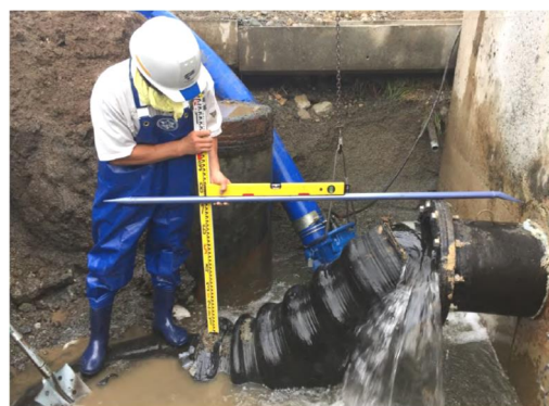
図-2 管水路の不同沈下による事故事例
