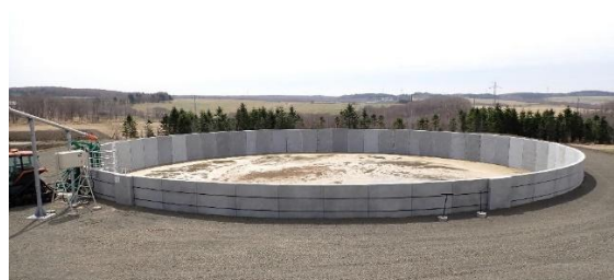
写真－1 配水調整槽
