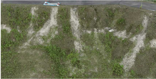
図-7 苦小牧川遊砂地における法面の変状（UAVによる3次元モデルの評価）
