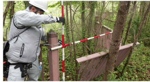
写真-6 覚生川3号遊砂地における安全柵の破損（目視による評価）
